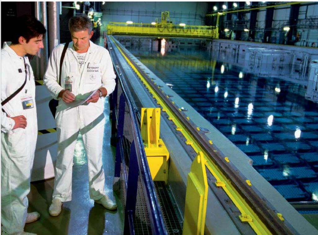
*Le combustible déchargé d'une centrale nucléaire est transporté jusqu'à l'usine de La Hague pour y être entreposé dans une piscine de refroidissement.*
