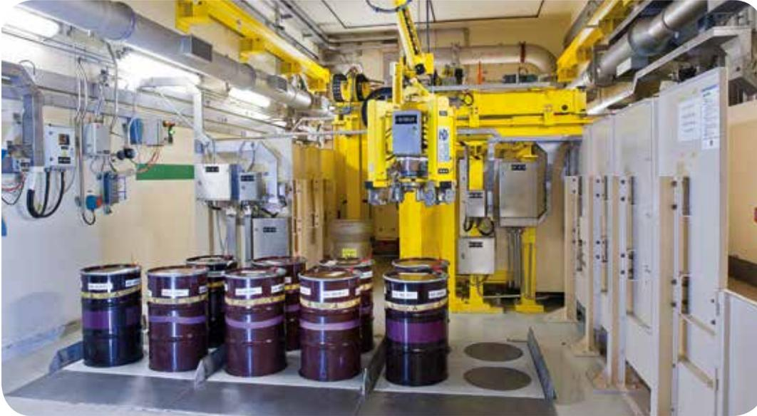
Mesure automatisée de matière radioactive dans des fûts de déchets
