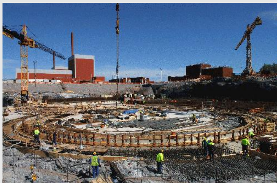
Le chantier durant l'été 2005
