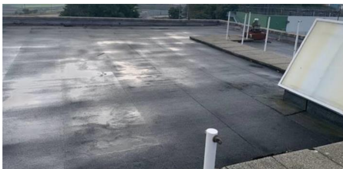
Toit du bâtiment de conduite des utilités vue Est
