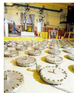
Figure 59 : Photo du sommet des puits d'entreposage de l'installation CASCAD du CEA/Cadarache
