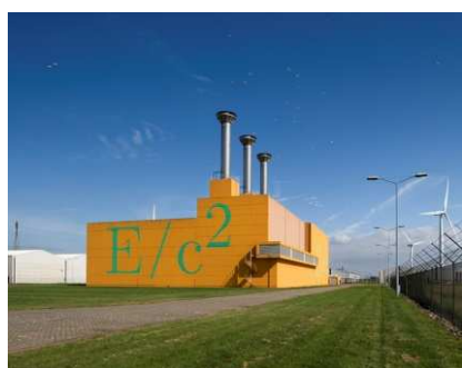
Figure 60 : Photo extérieure de l'installation HABOG (Borsele - Pays-Bas)
