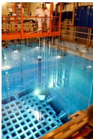
Figure 2 : Photo d'une piscine BK
