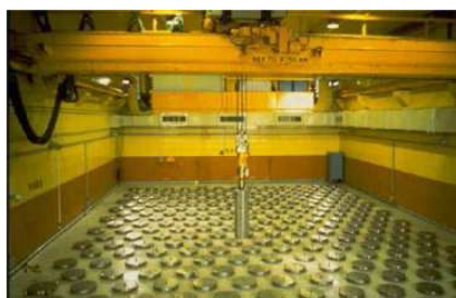
Figure 58 : Photo de la cellule de déchargement et de manutention de l'installation CASCAD du CEA/Cadarache
