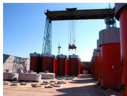
Figure 54 : Entreposage en emballages CASTOR® sur le site de la centrale d'Ignalina (Lituanie)
