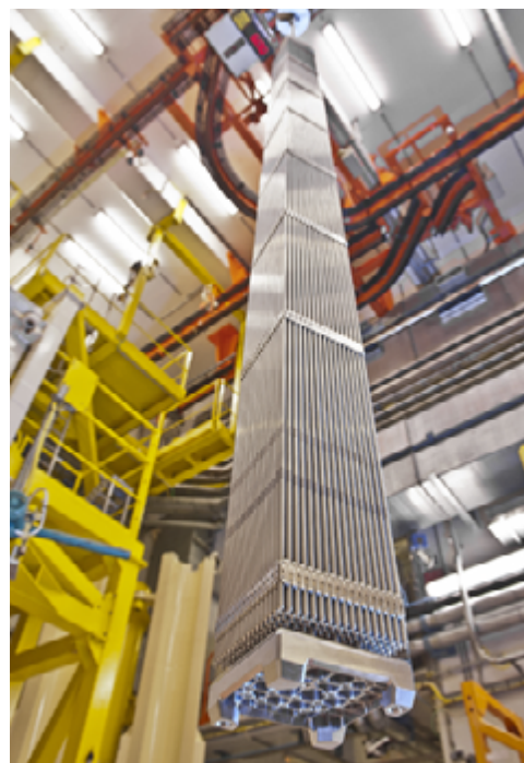
Assemblage du combustible MOX en zone de chargement sur le site d'Orano Melox
