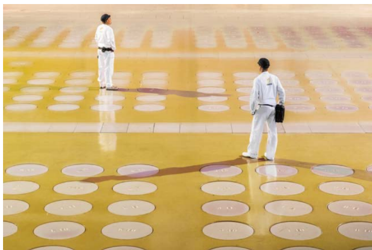
Figure 7 : Entreposage de colis CSD-V - Orano la Hague
