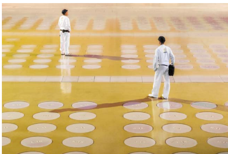
Figure 7 : Entreposage de colis CSD-V - Orano la Hague
