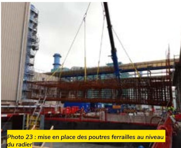
Photo 23 : mise en place des poutres ferrailles au niveau du radier
