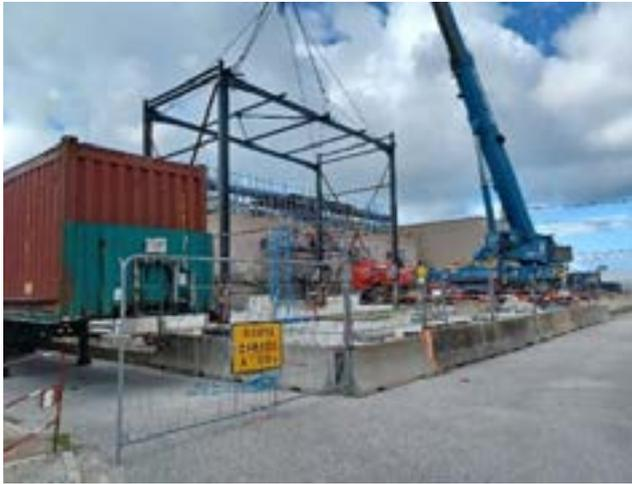
Photo 16 : dépose de l'ancienne charpente du silo 115
