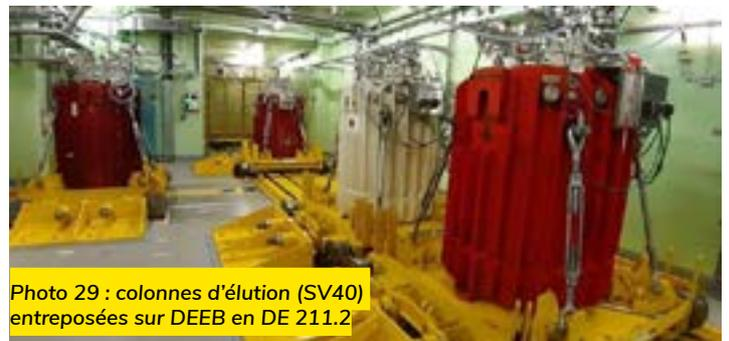
Photo 29 : colonnes d'éluion (SV40) entreposées sur DEEB en DE 211.2
