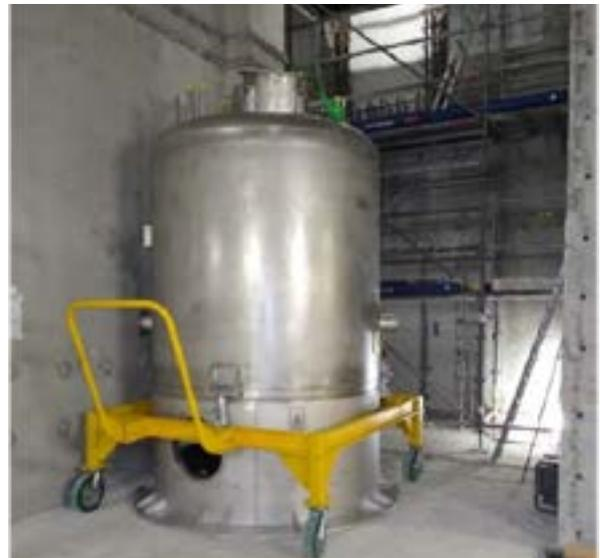
Photo 24 : introduction de la cuve de traitement dans le bâtiment
