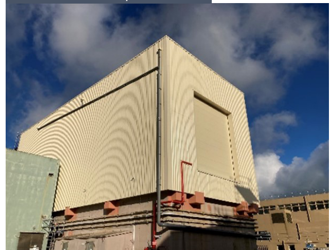
Photo 11 : nouvelle charpente silo 115
