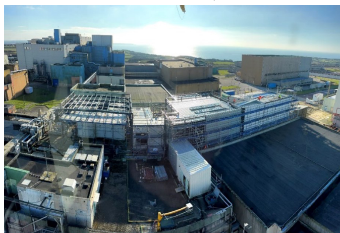
Photo 15 : photographie panoramique des Toits de Silos prise depuis le Nord du Bâtiment 114.1
