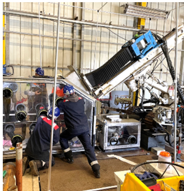
Photo 9 : foreuse réalisant les prises d'échantillons de terres et gravats dans la fosse 43 du silo
