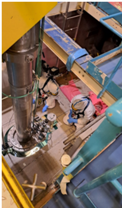
Photo 7 : essais du pont perche S1 - réglage de la caméra de visée des curseurs
