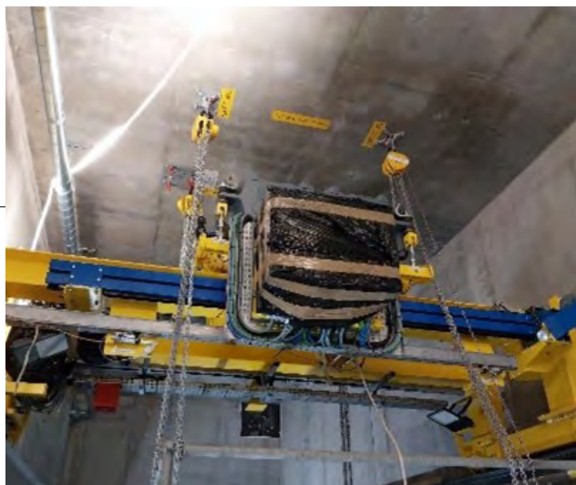
Photo 23 : Pont de manutention des colis CBFC2-DFG
