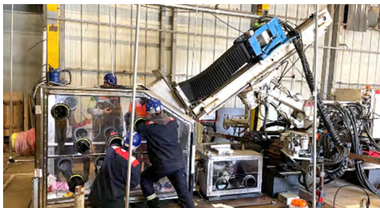
Photo 9 : foreuse réalisant les prises d'échantillons de terres et gravats dans la fosse 43 du silo
