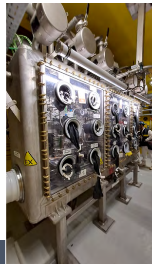
Photo 30 : boîte à gants des équipements de transfert
