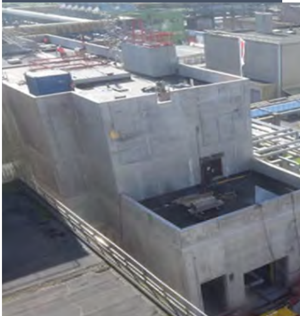
Photo 22 : vue du bâtiment de cimentation
