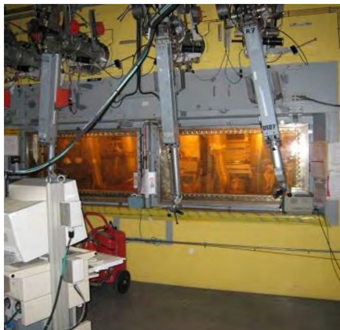
Photo 26 : traitement des fûts dans l'UCD
