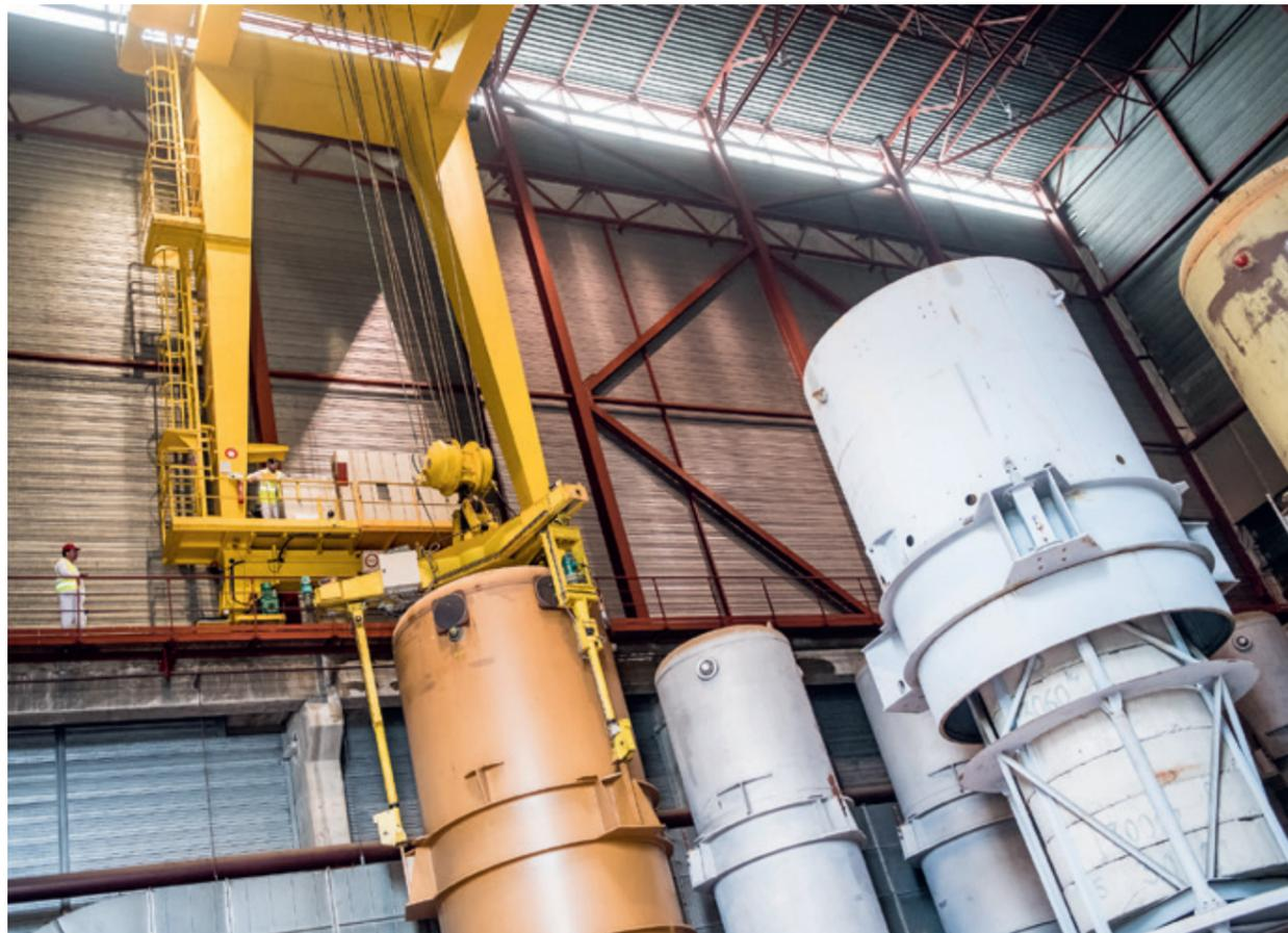
**Le démantèlement concerne les 1 400 étages de la cascade de diffusion soit 160 000 tonnes d'acier à démanteler (l'équivalent d'une vingtaine de Tour Eiffel), 30 000 tonnes d'équipements métalliques et plus de 1 300 kilomètres de tuyauterie.**
