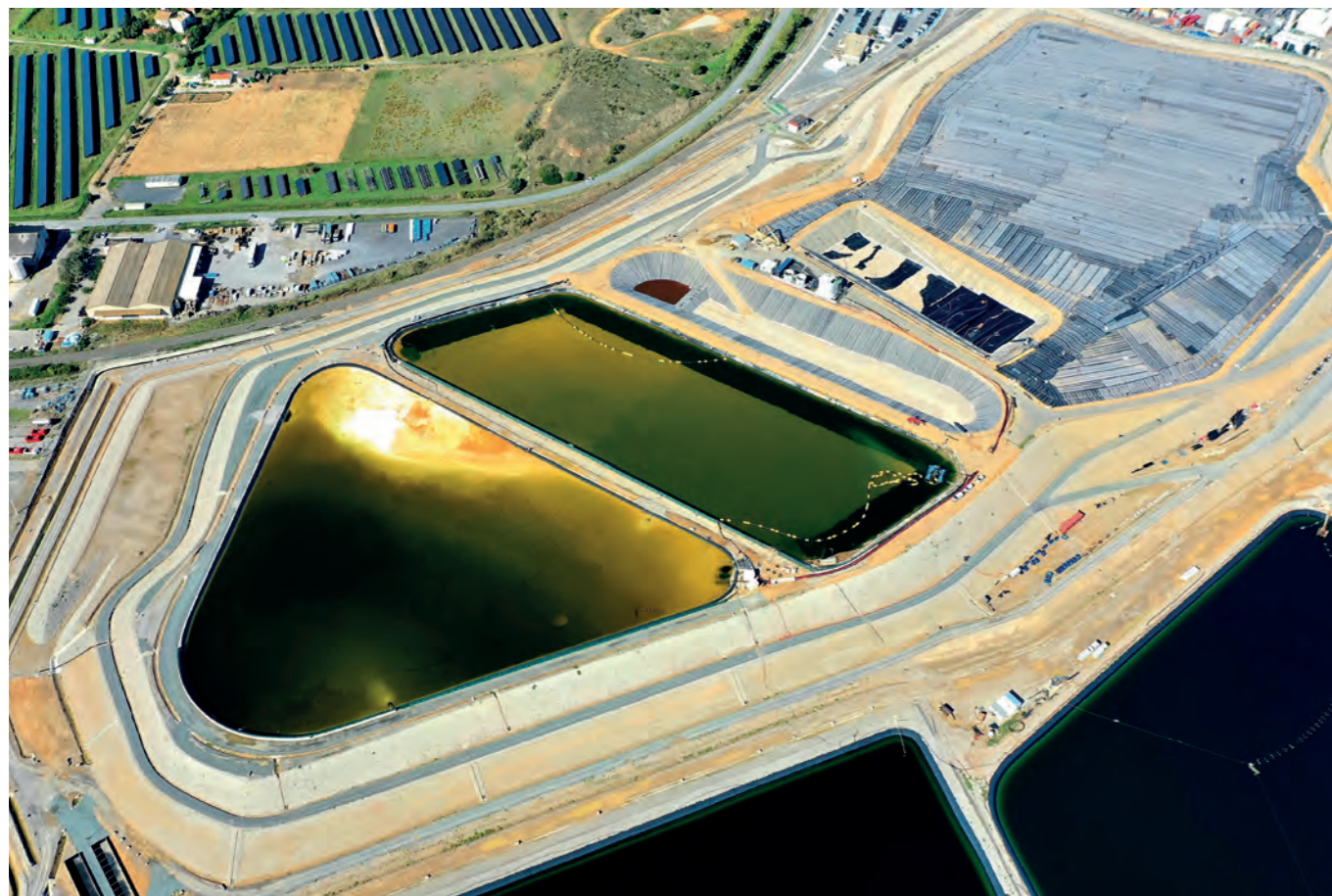
Vue aérienne de la zone lagunaire avec les bassins de décantation B5/B6, les alvéoles PERLE-CERS et la couverture étanche de l'INB ECRIN
