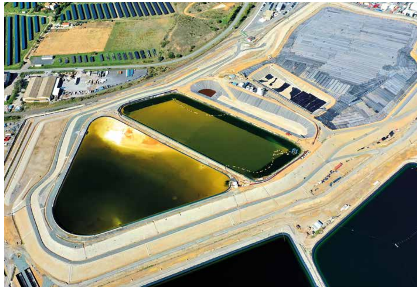
Vue aérienne en 2020 de la zone lagunaire avec les bassins de décantation B5/B6, les alvéoles PERLE-CERS et la couverture étanche de l'INB ECRIN (avant travaux de finalisation du remplissage et du recouvrement de l'alvéole PERLE).
