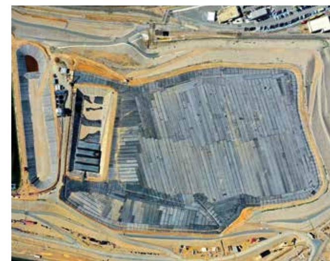
Couverture bitumineuse-INB ECRIN
