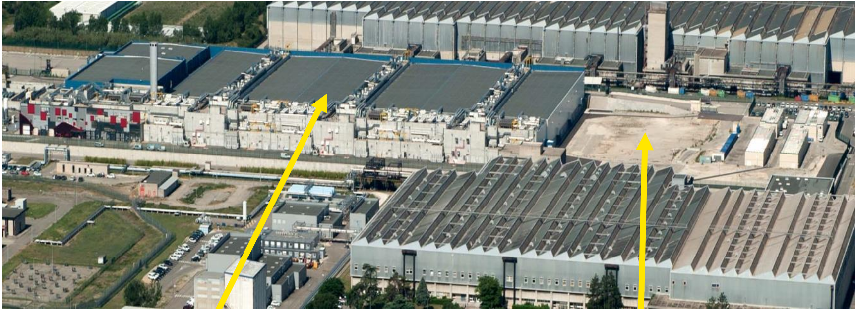
Usine Georges Besse 2 Nord
